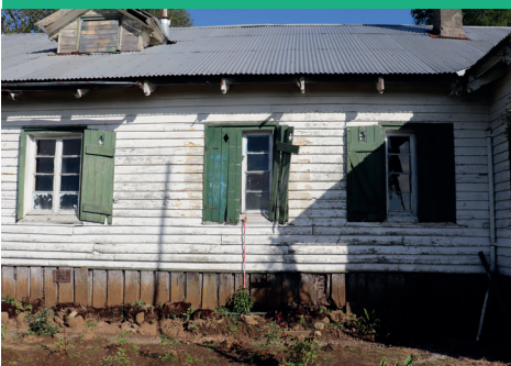
Vista General del Inmueble
