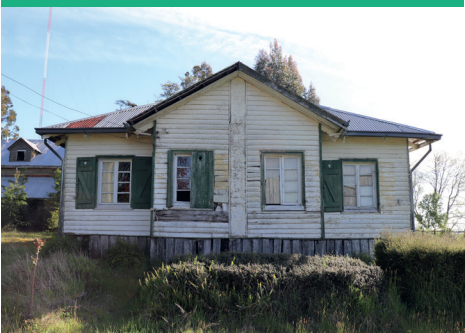
Vista General del Inmueble
