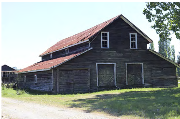
Galpón del conjunto agropecuario, sector Calle Calle
